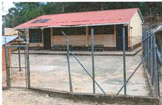
Foto 2: Reparación y cambio de losa de patio
