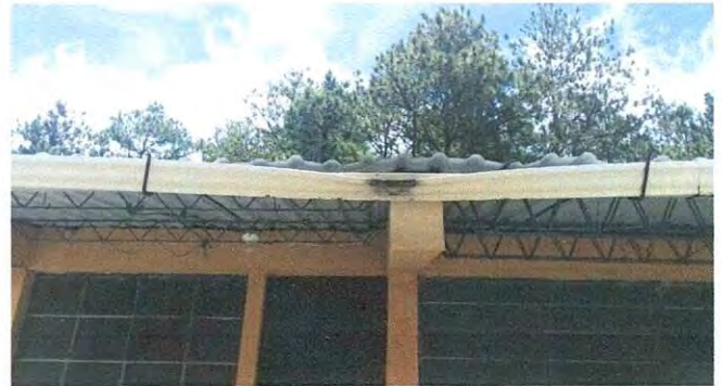
Foto 4: Reparación de canales y bajadas de agua pluvial
