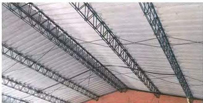
Foto1: Reparación y cubierta de lámina
