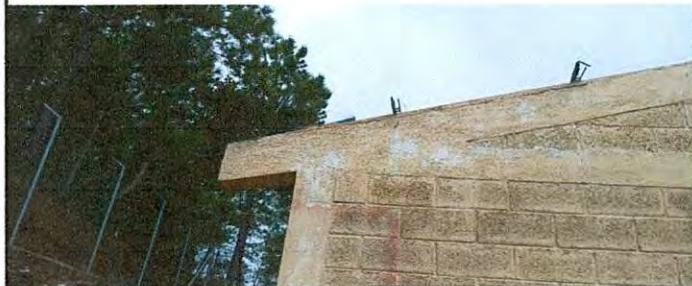
Foto 4: Pintura interior y exterior de instalaciones
