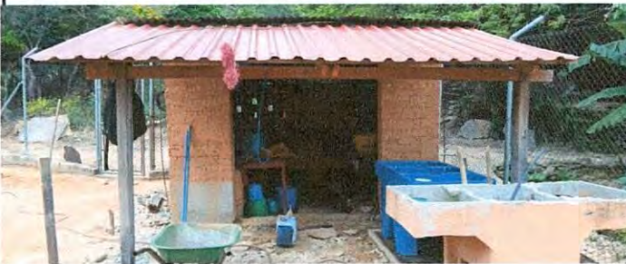
Foto 3: Reparación de cocina
