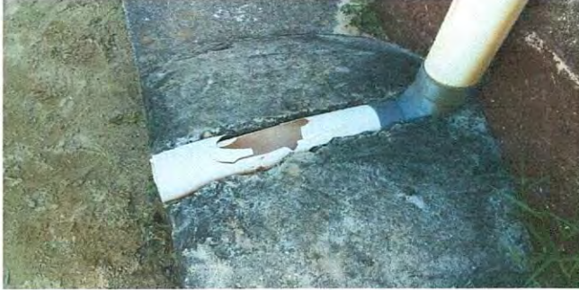
Foto 1: Reparación de canales y bajadas de agua pluvial
